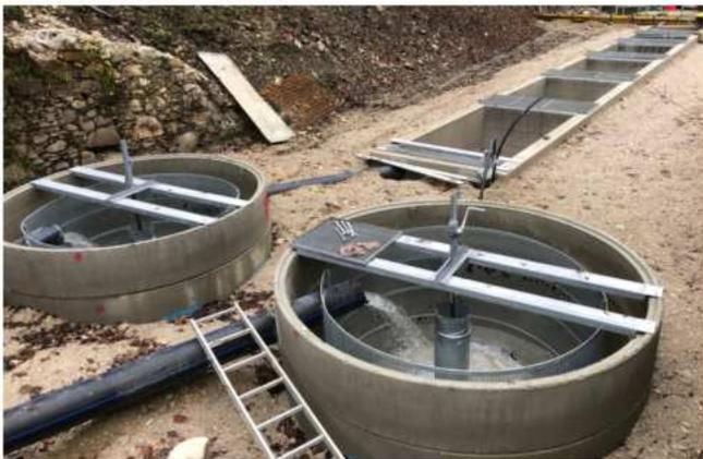
Die Fischzuchtanlage wird auf Grundbesitz der Bundesforste innerhalb der Grundmauern eines ehemaligen Gebäudes (Sägewerkes), von dem noch Mauerreste vorhanden sind, errichtet. Ausgeführt wird dieser als 20,5 Meter langer und 2,5 Meter breiter Fließkanal mit einer Tiefe von 1,4 Metern. Interessant sind auch die Vorschriften in den Gutachten für die Bauwerber.
